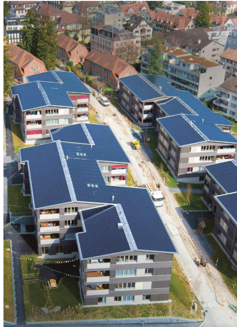
Lotissement de la Balberstrasse © Suntechnics Fabrisolar AG
